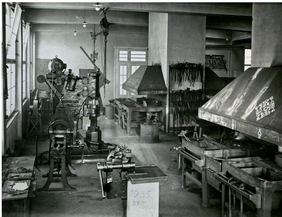
10. Interiéry kovářských a zámečnických dílen nové školní budovy na Pospíšilově třídě, soukromá sbírka.
