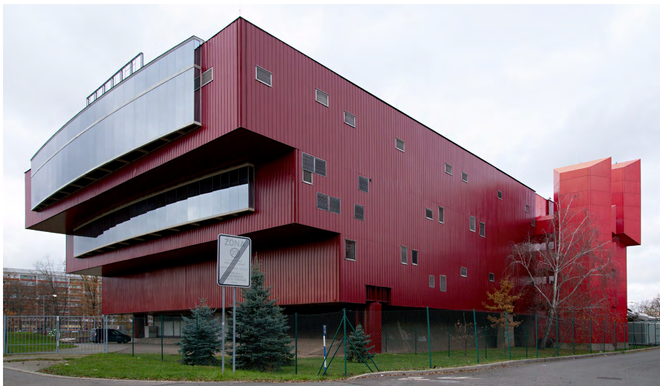
3. Tranzitní telefonní ústředna v Hradci Králové, technologická budova, foto: Jakub Potůček 2020.
