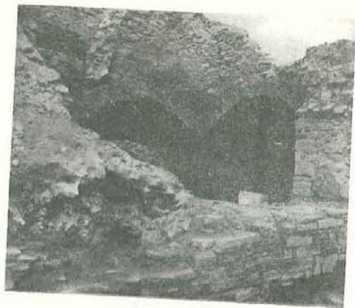
Vizmburk, objekt kuchyně, pohled od JZ.
