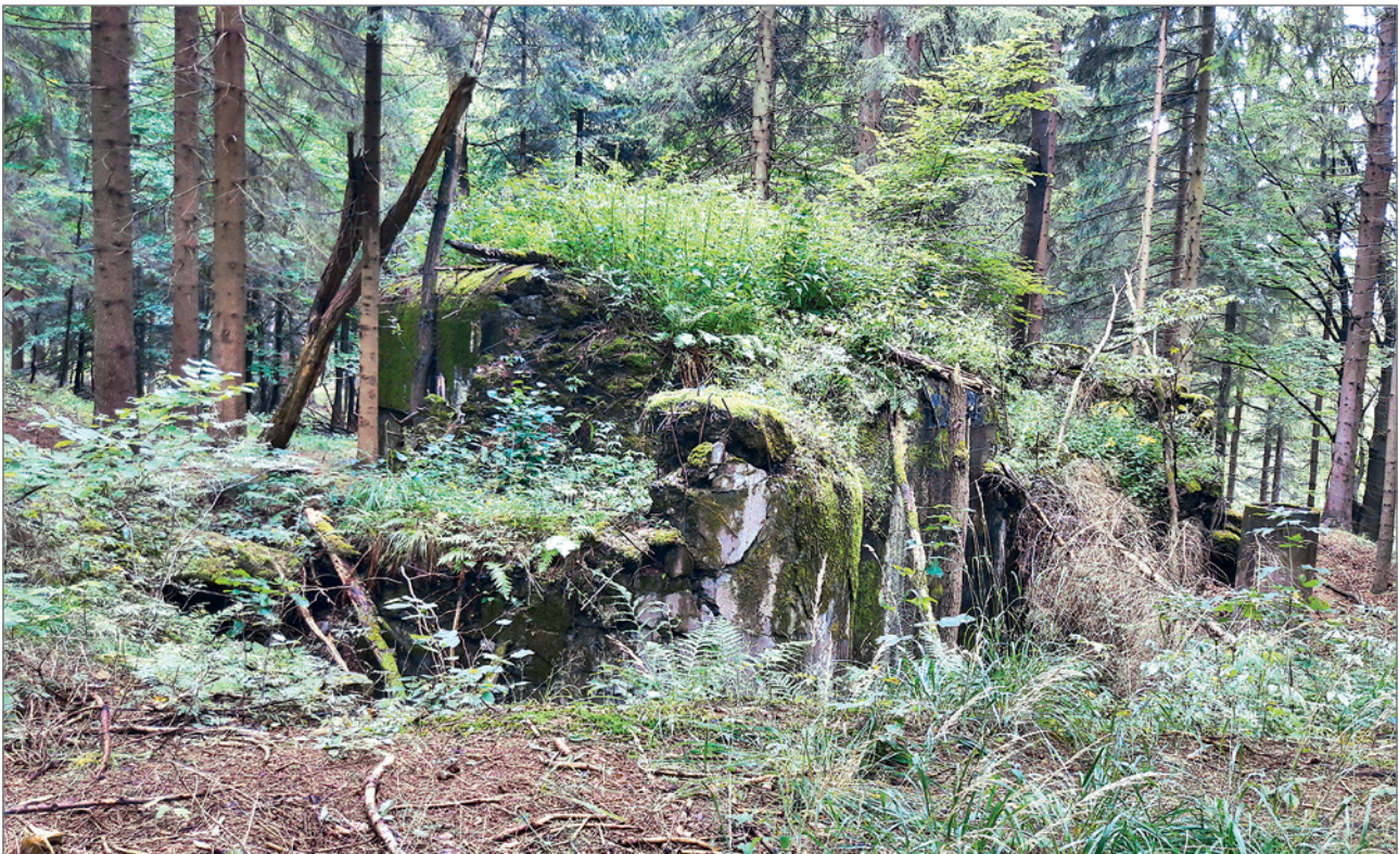
Obr. 6. Jeden z objektů opevnění v seg. 2, izolovaný pěchotní srub R-S 55 Na palouku, 13. VIII. 2019 Fig. 6. One of the object of border defense R-S 55 Na palouku in the segment 2, 13 Aug 2019. Foto/Photo T. Tejklová)
