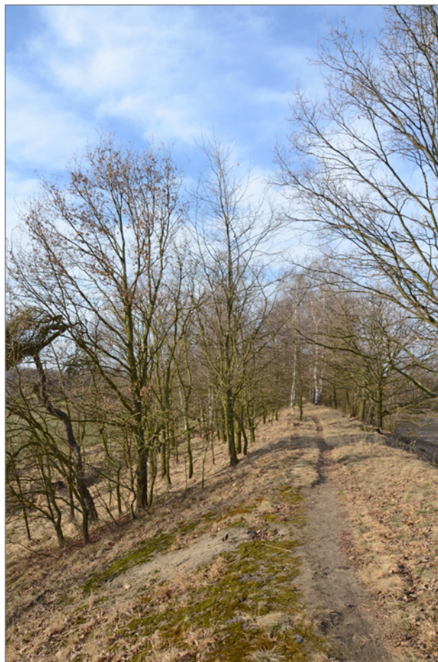
Obr. 8. Hráz bývalého rybníka Rozkoš (lokalita 10), 11. III. 2011 Fig. 8. Dam of former Rozkoš pond, locality 10, 11. III. 2011 (Foto/Photo B. Mocek)
